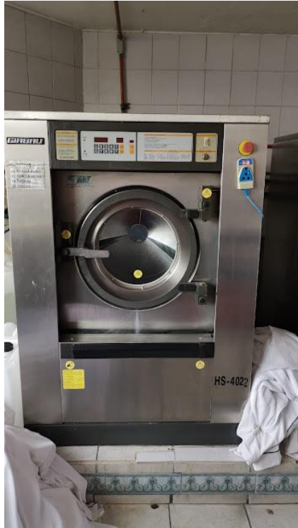
Antes de intervención
